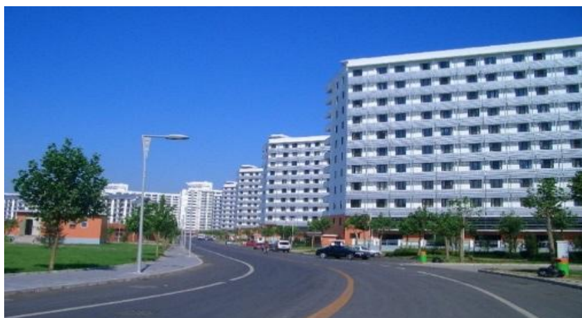
公寓建筑群（紫荆学生公寓 19-23 号楼）
